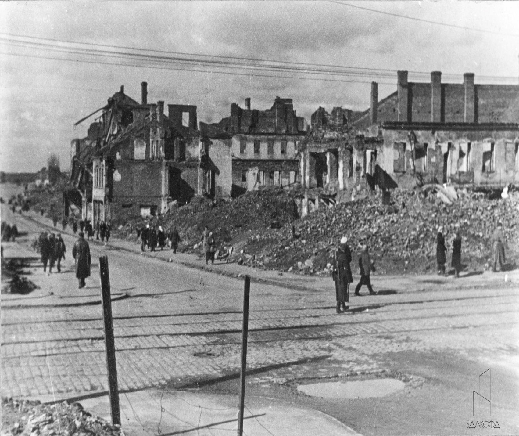
Минск. Разрушения по Ленинской улице.
