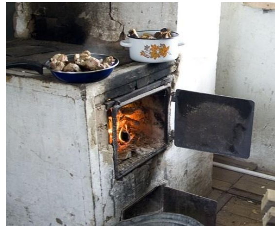
топочная дверца печи неисправна (не закрывается)
