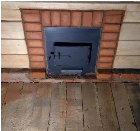
участок пола из горючих материалов (доска, паркет и другое) перед топочным отверстием печи не защищен негорючим материалом (металлический лист, плитка и т.д.)
